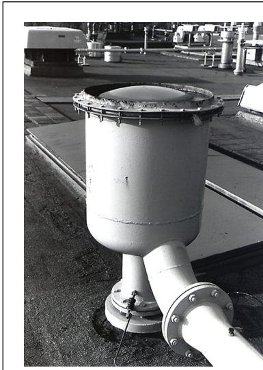
Fig. E.2.2-1. Explosion diverter
